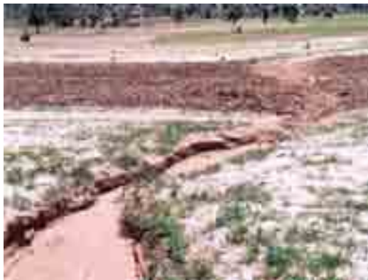
Érosion sur sol sableux ferrugineux
