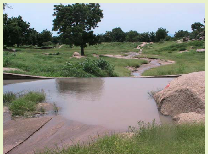
Photo 11 : Bief en pierres maçonnées.
