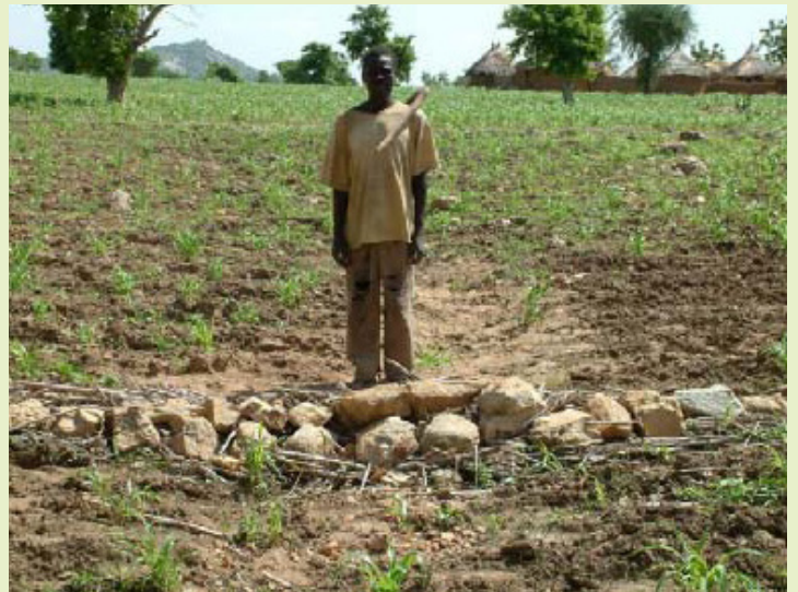
Photo 10 : Bief en pierre calées réalisé en champs
